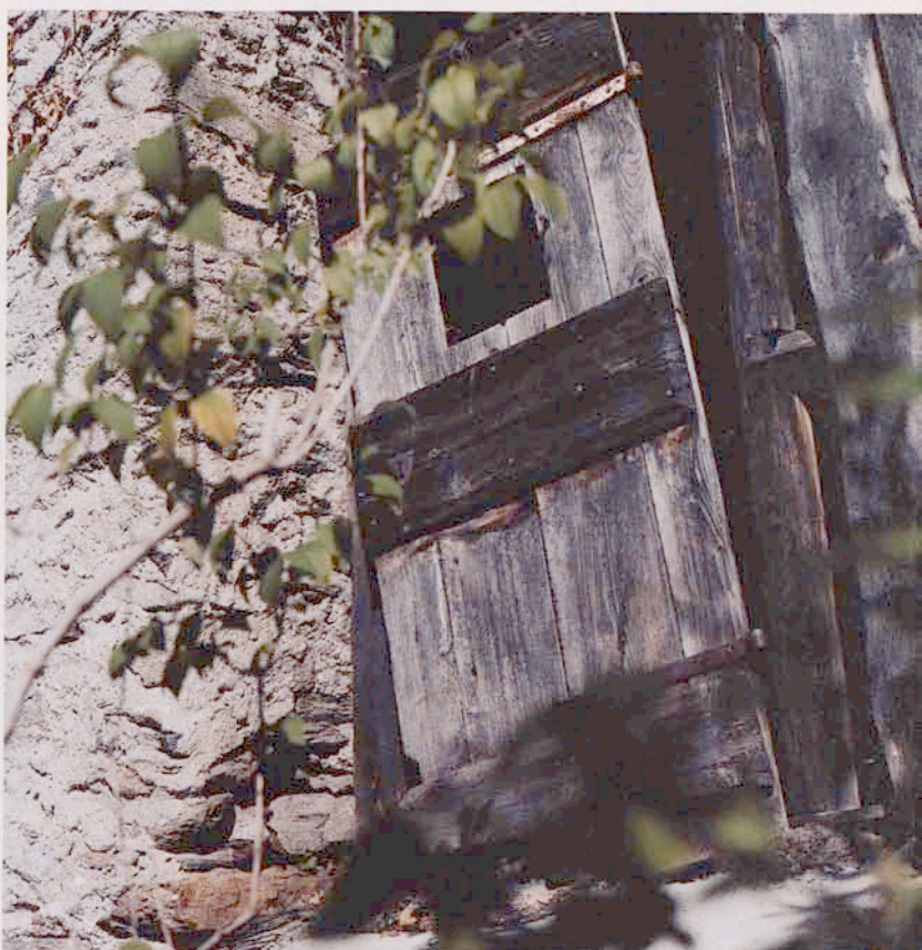
Von oben links im Uhrzeigersinn: Im Dachstock der Villa Garbald. Sicht aus der Villa.
