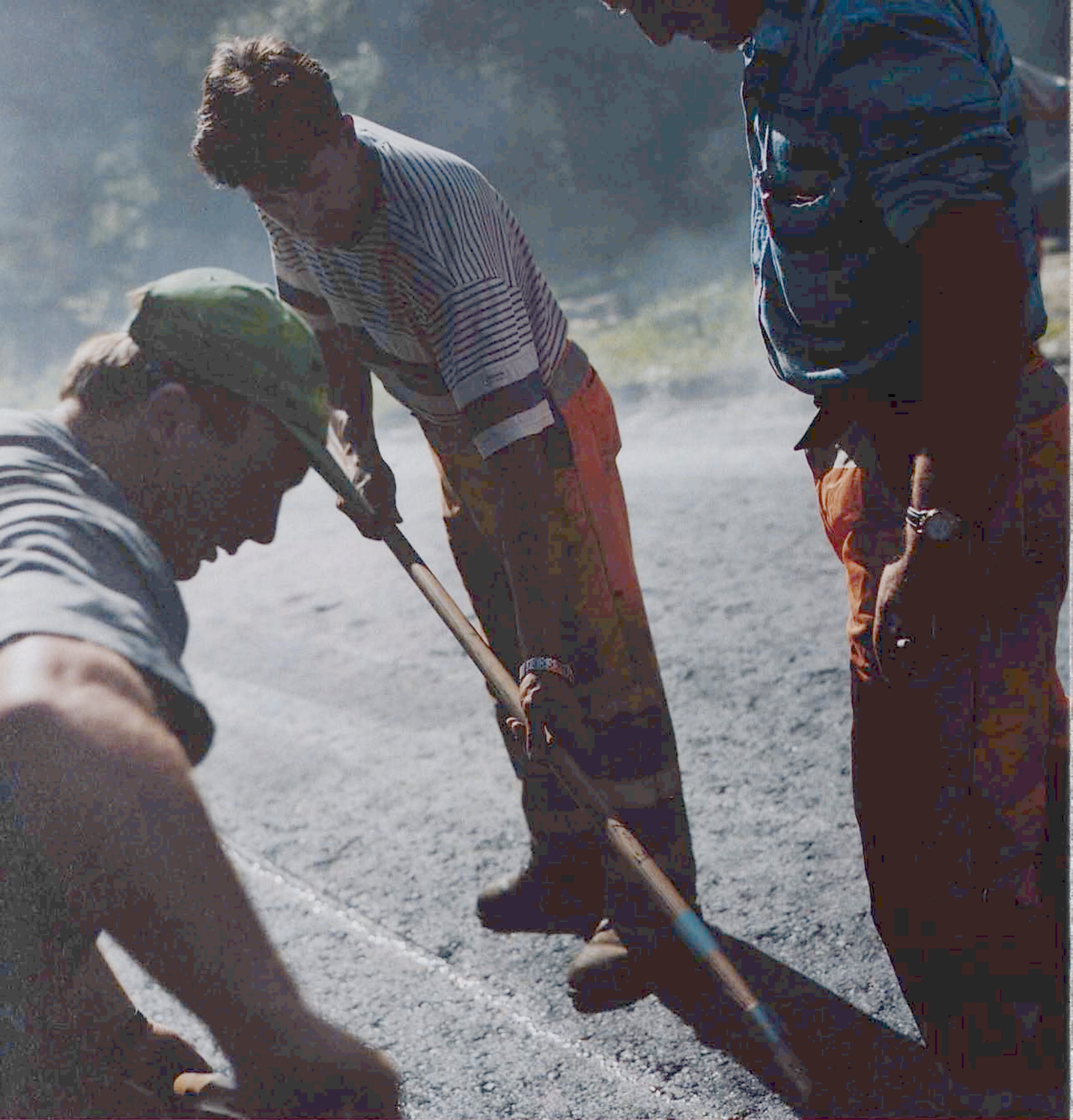
Strassenbau vor Vicosoprano.
