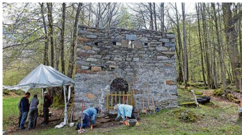
Vorbildlich restauriert: Archäologische Untersuchungen am spätmittelalterlichen «Steinhaus» in Bondo-Casnàcc.
