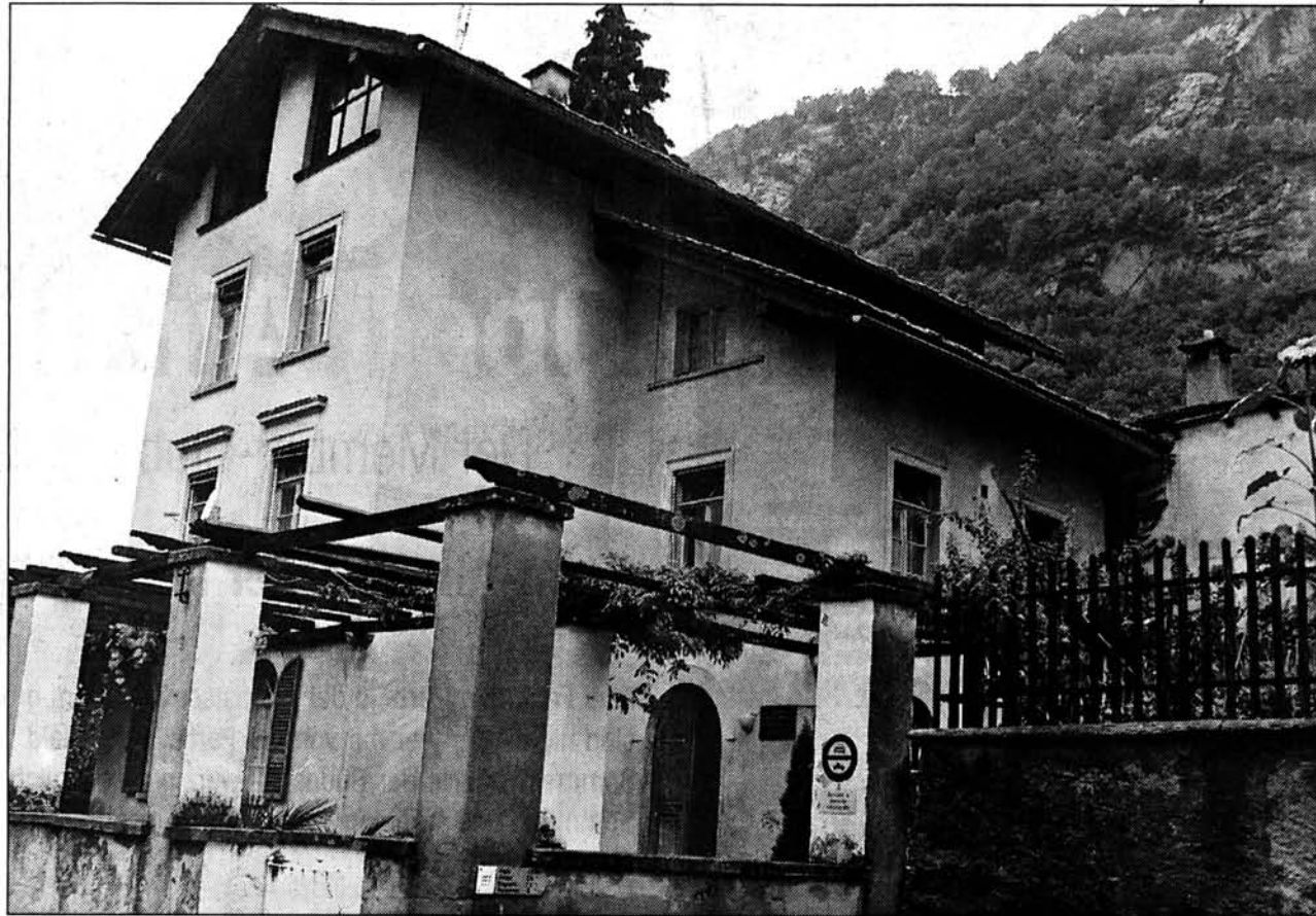
Grosszügige Heimatschützer: Der BHS führt einen Architekturwettbewerb für die Erweiterung der Villa Garbald in Castasegna durch.
