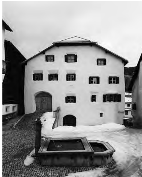
Abb. 250: Ardez, Haus Nr. 69. Platzfassade.
