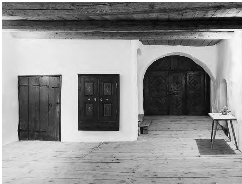
Abb. 256: Ardez, Haus Nr. 69. Der "Piartan" (Durchfahrt zum Heustall). Der Raum wurde nur instandgestellt und blieb so original erhalten. Auf Heizkörper wurde bewusst verzichtet. Temperiert wird der Raum durch im Aussenwandverputz verlegte Heizrohre.
