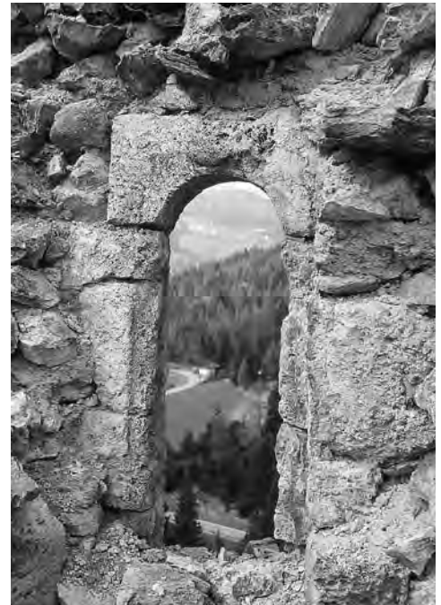
Abb. 211: Brienzen/Brinzauls, Burgruine Belfort. Südtrakt, West-Innenwand, Rundbogenfenster in Tuffstein zu Saal im vierten Geschoss. Ansicht von Osten.
