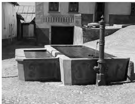
Abb. 264: Tschlin, Aussenräume. Die Brunnentröge aus Beton von 1905 haben durch die Restaurierung den ursprünglichen Charakter zurückerhalten. Der Brunnenstock dient gleichzeitig als Hydrant.
