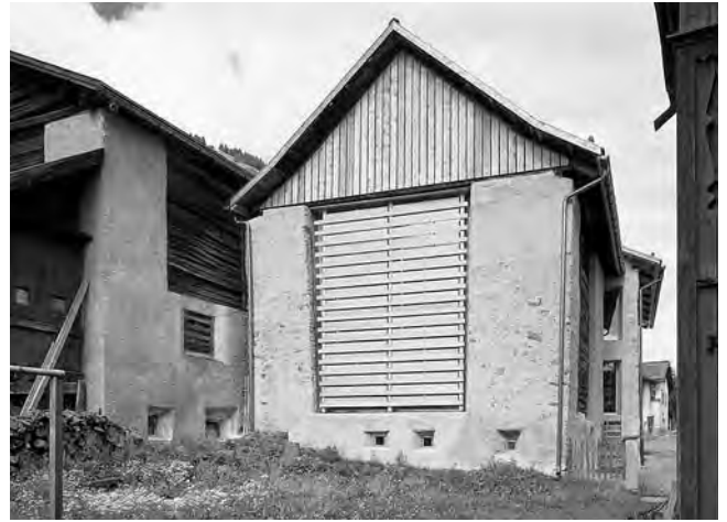
Abb. 244: S-chanf, Haus Nr. 120. Heustallfassade. Die Heubelüftungsöffnungen wurden von innen verglast und nach aussen mit einer groben verstellbaren schattenspendenden Lamellenkonstruktion versehen. Das „Bild“ ist neu, das Wesen des Gebäudeteils erhalten.
