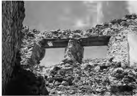
Abb. 212: Brien/Brinzauls, Burgruine Belfort. West-Innenwand, Doppelfenster zur jüngsten Umbauphase 5. Ansicht von Osten.
