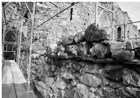
Abb. 213: Brien/Brinzauls, Burgruine Belfort. Westfassade, vorkragender Steinplattenkranz in der jüngsten Aufhöhung. Ansicht von Südwesten.
