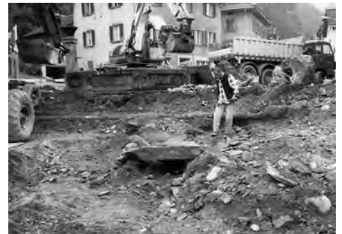
Abb. 142: Sils i. D., Sanierung Hauptstrassen. Freilegung des Abwasserkanals unmittelbar nördlich des Dorfbrunnens. Blick von Norden.
