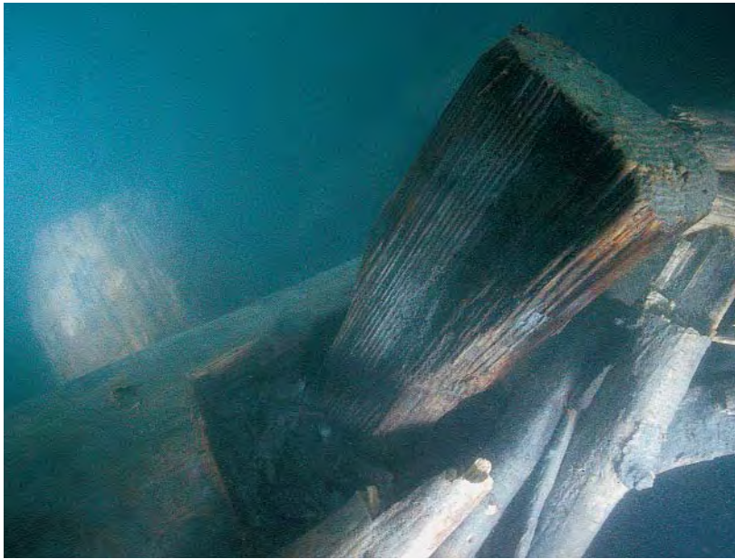
Abb. 89: Untervaz, Kiesgrube. Unterwasser-Aufnahme einer Kastenecke mit senkrecht durchgeschlagenem Pfahl und Ästen der Abdeckung.
