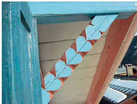
Abb. 105: Lumbrein, Cas'aulta Nr. 120. Detail Dachpfette.
