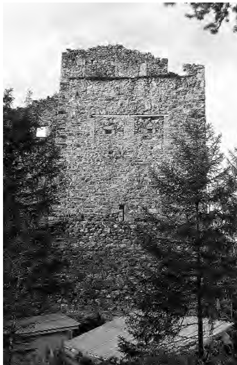
Abb. 130: Brien/Brinzauls, Burgruine Belfort. Ansicht Nordfassade.
