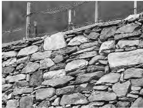
Abb. 106: Verdabbio, restaurierte Trockenmauer.
