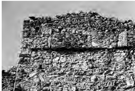
Abb. 133: Brienzen/Brinzauls, Burgruine Belfort. Nachträglich zugemauerte Zinnen über der Nordfassade.
