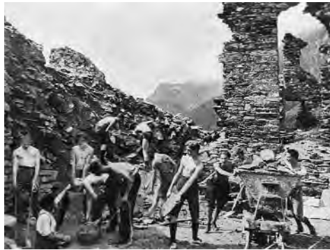
Abb. 100: Mesocco, Castello, während der Sicherungskampagne 1925/26. Grossflächiges Ausräumen des Schuttes durch die «Pro Campagna» unter der Leitung von Eugen Probst.
