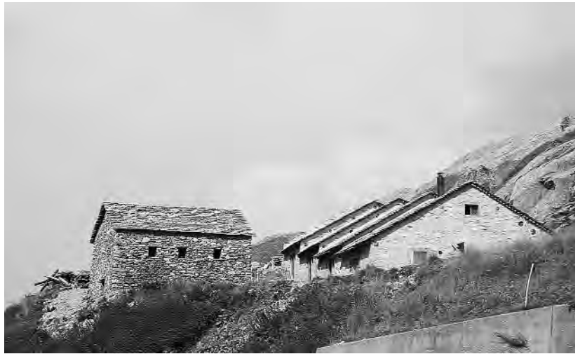
Abb. 175: Medel (Lucmagn), Alp Stgegia. Detail des Steinplattendachs auf dem Genossenschaftsstall.
