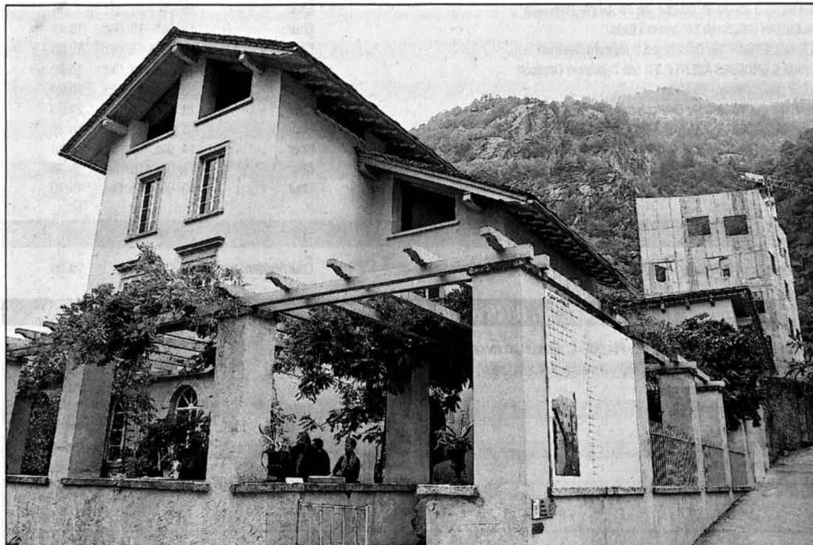
Nach regelrechtem Dornröschenschlaf zu neuem Glanz gebracht: die alte Gottfried-Semper-Villa Garbald», im Hintergrund das Gästehaus Roccolo noch im Rohbau. (Ky)
