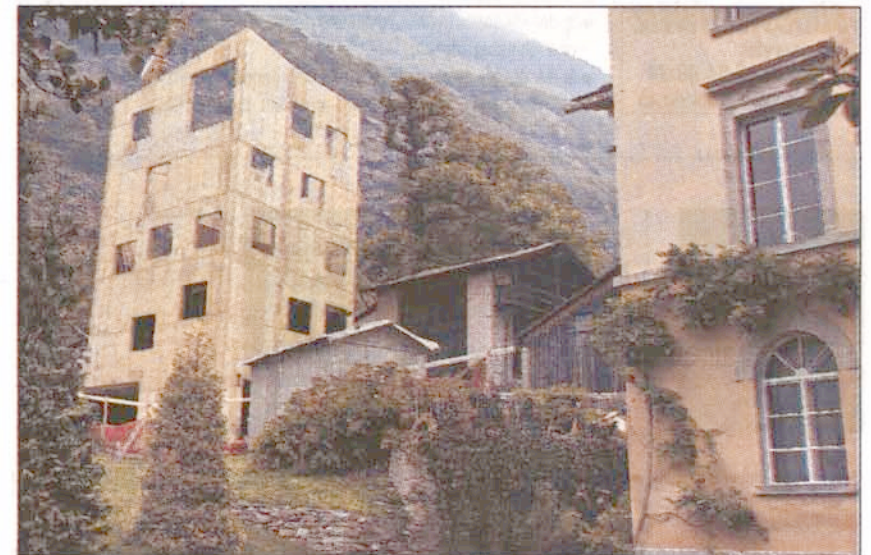
Im Dienste der ETH Zürich: Das Gästehaus Roccola der Architektinnen Paola Maranta und Quintus Miller soll nächsten Frühling bezugsbereit sein.
